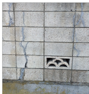
▼写真1 明らかに古い壁
